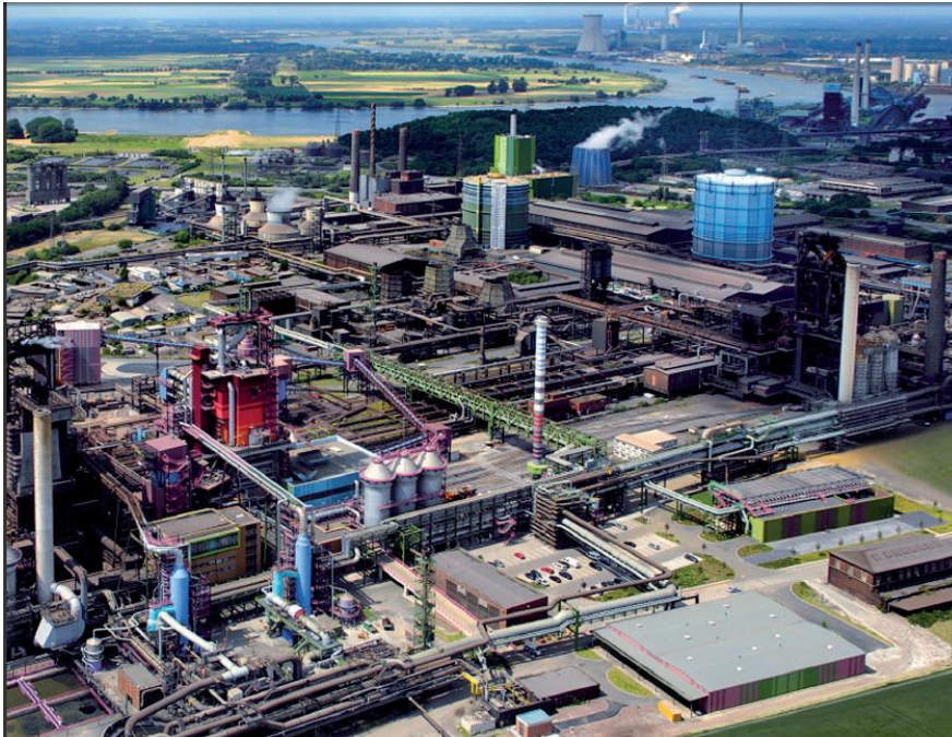
Fig. 1 - Vista generale degli impianti
