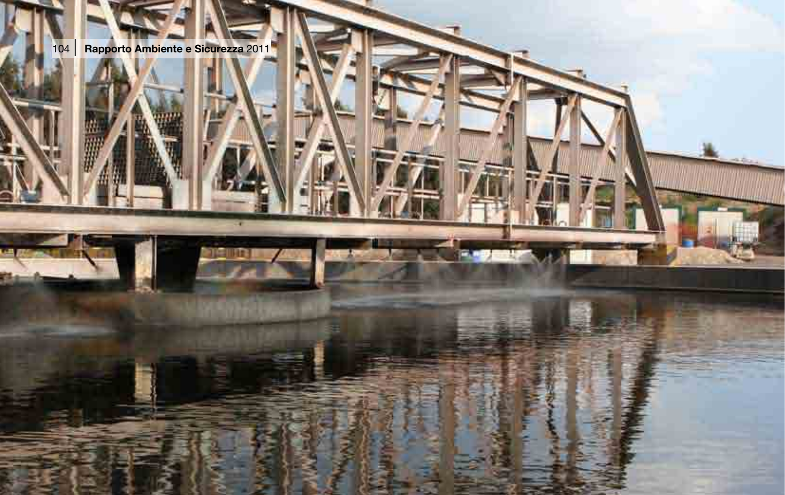
Figura 84 Decantatore circolare
