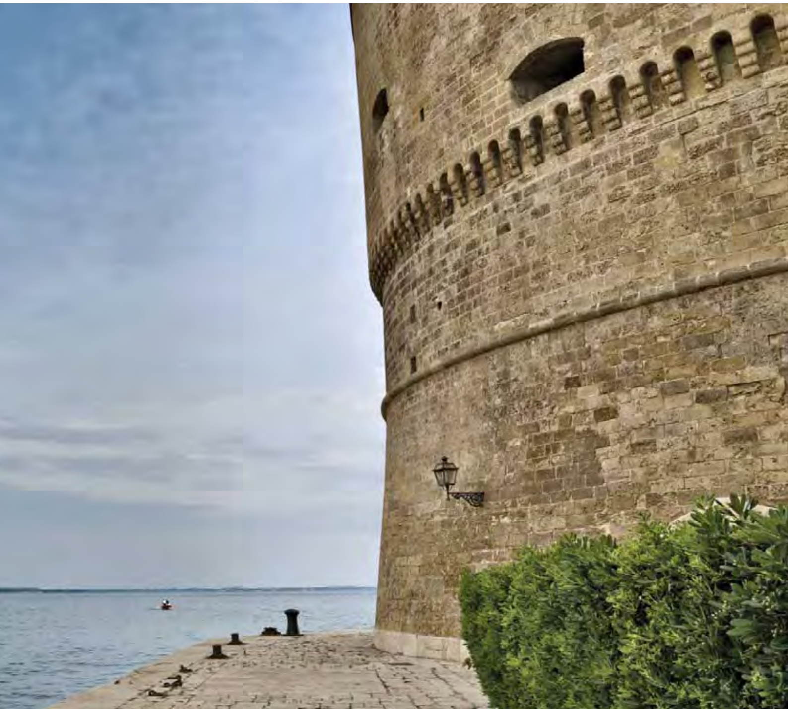
Figura 33 Taranto. Castello Aragonese e canale del Ponte Girevole
