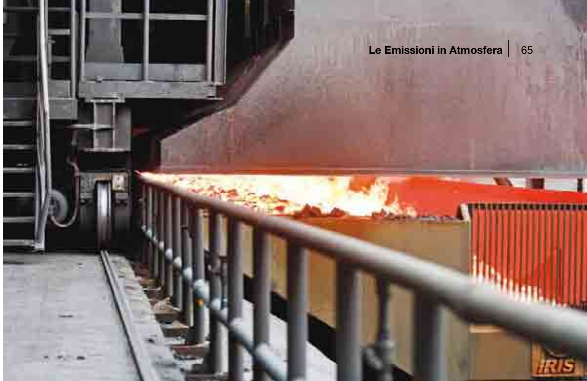
Figura 43 Fase aspirazione fumi allo sfornamento del coke
