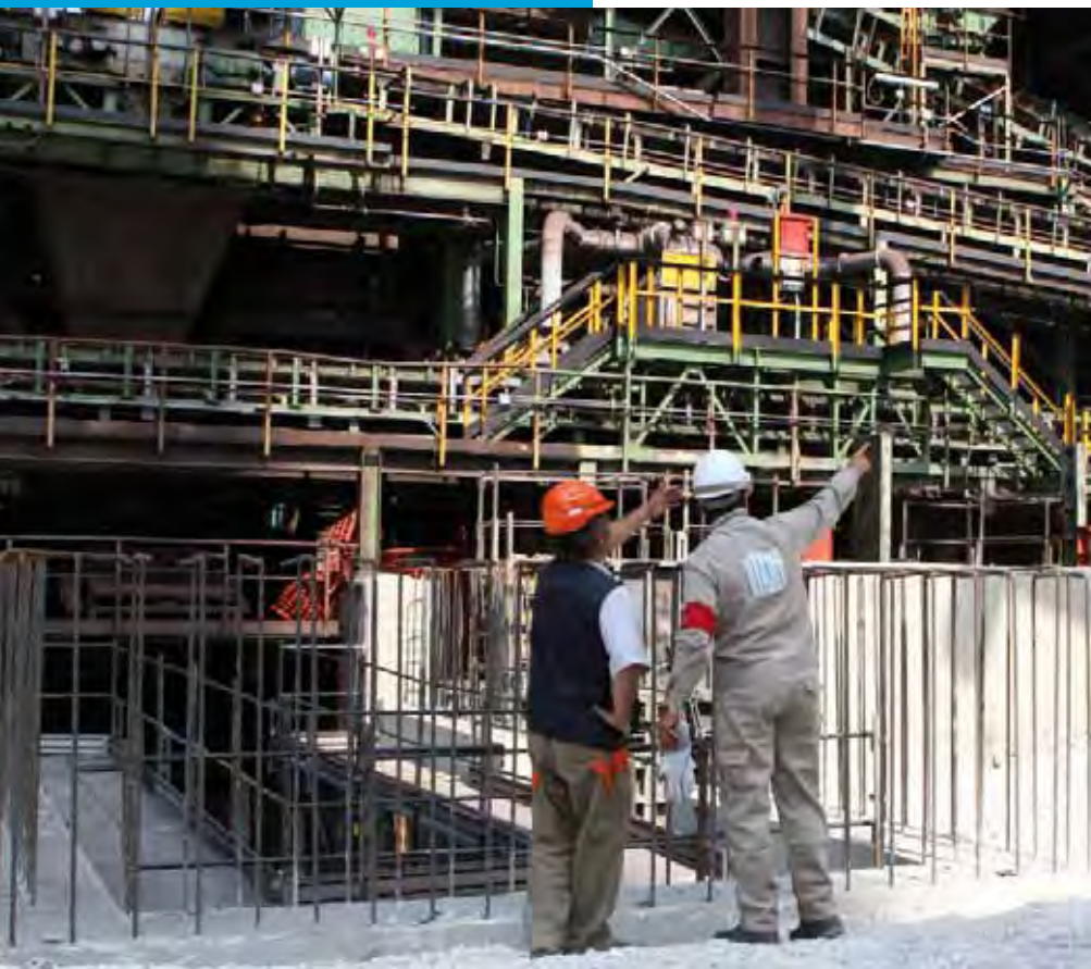
Figura 127 Cantieri di lavoro
