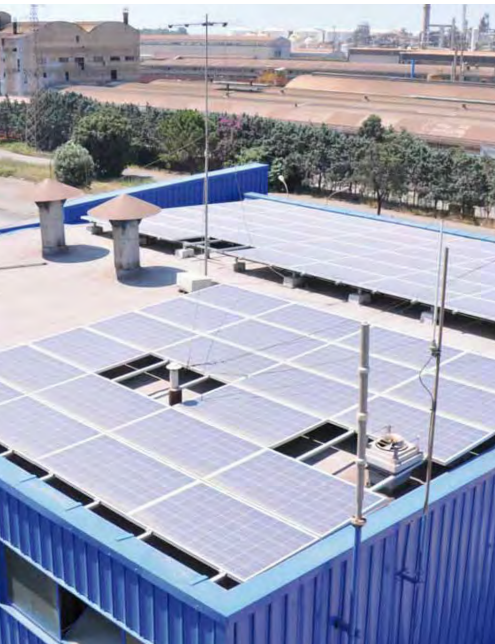
Figura 73 Pannelli fotovoltaici sulla palazzina Direzione
