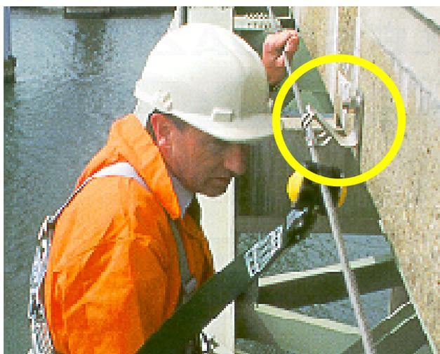
Se un dispositivo di ancoraggio comprende più di un elemento, la progettazione deve essere tale che quegli elementi non possano apparire correttamente assemblati senza essere saldamente bloccati tra di loro. I bordi o gli angoli esposti devono essere arrotondati con un raggio di almeno 0,5 mm o con uno smusso di 45°.
