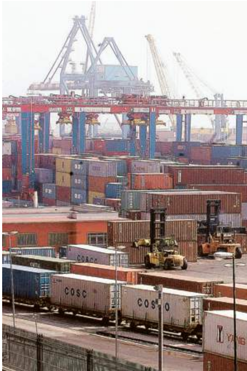
L'attuale area container del porto di Napoli
