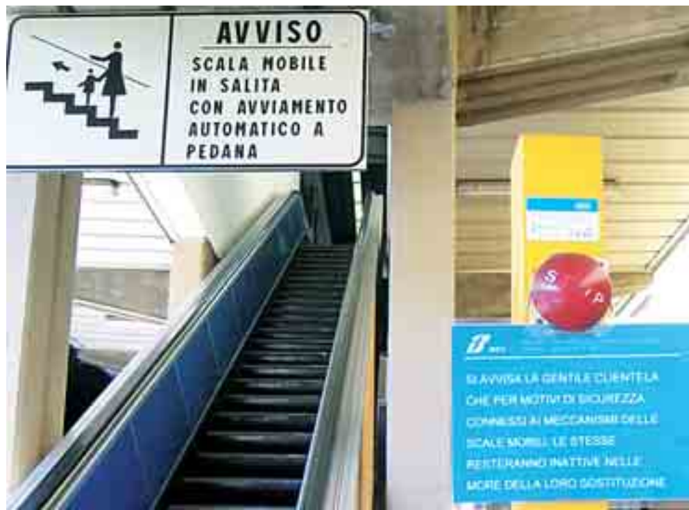
LA SCALA MOBILE DELLA STAZIONE NOTARBARTOLO DA MESI «FUORI USO»
