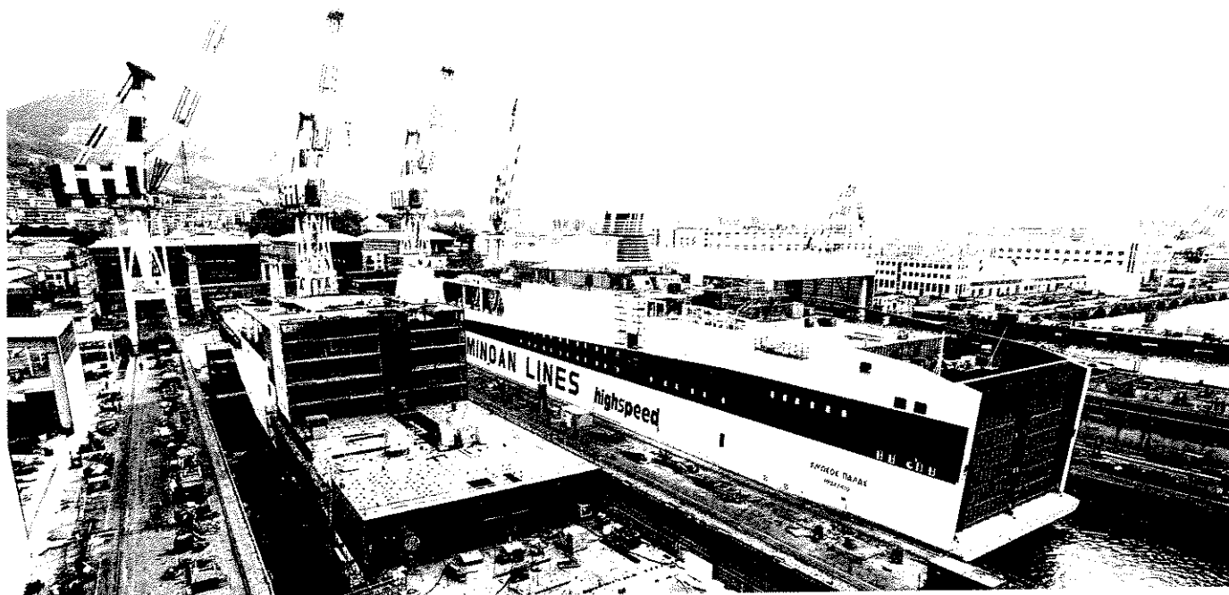
Il cantiere di Sestri Ponente
